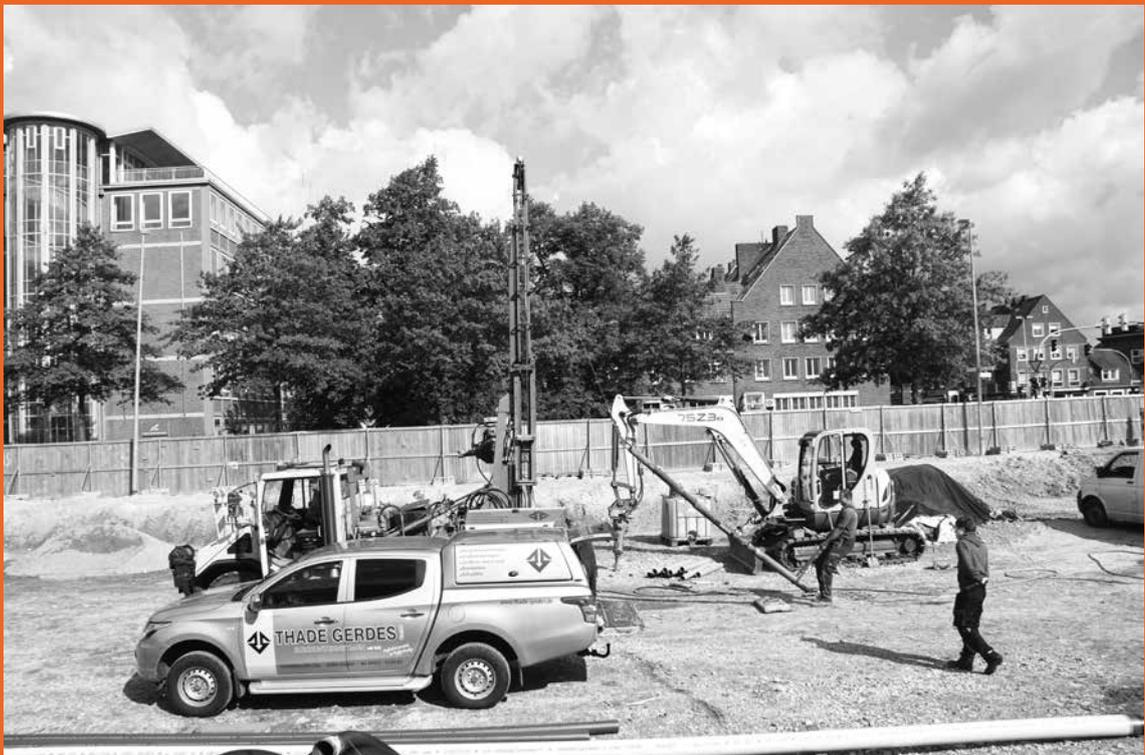
*Mittels transportablem Bohrgerät wurden in Emden an den Neutor-Arkaden Kernbohrungen zur Ermittlung der Stratigraphie und der Bebauungsstrukturen gezogen (Foto: Hardy Prison, Ostfriesische Landschaft).*
