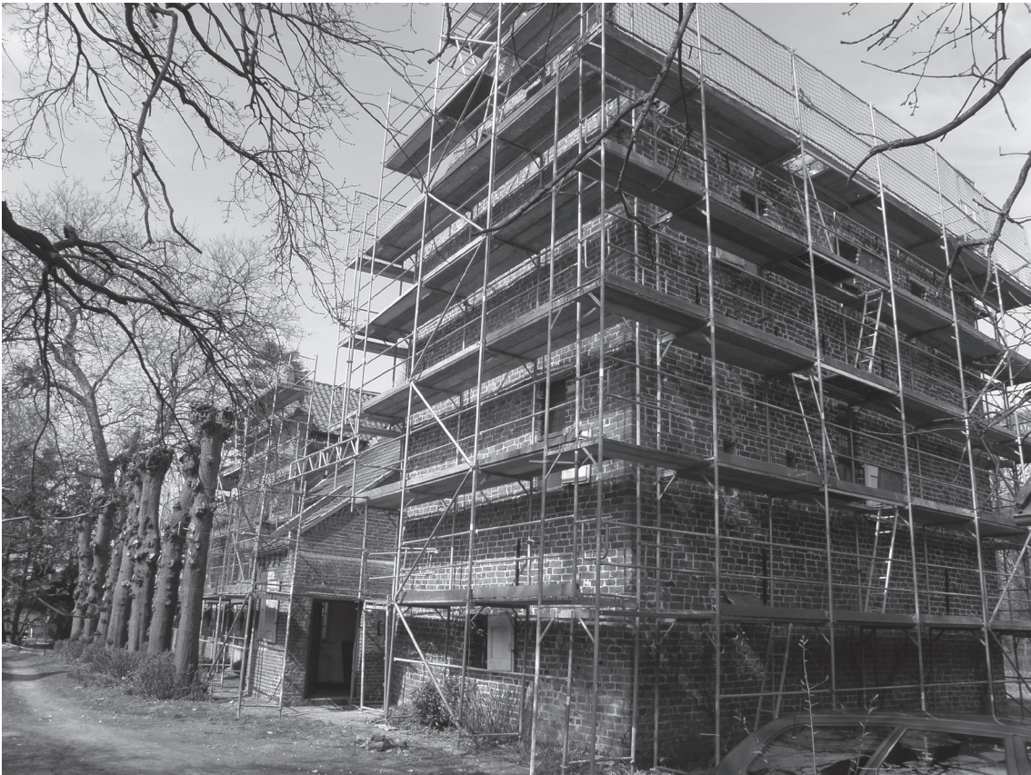
a–d: Das Steinhaus Bunderhee während der Sanierung im Sommer 2010 (Fotos: Rolf Bärenfänger)
