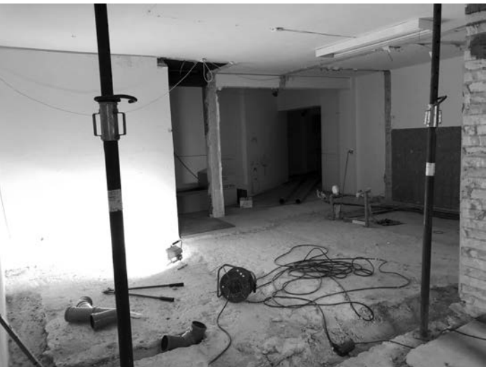
Sanierungsarbeiten im Museum „Leben am Meer“ in Esens. Hier entsteht ein neuer Sanitärbereich (Foto: Anke Kuczinski, Museum „Leben am Meer“ Esens).
