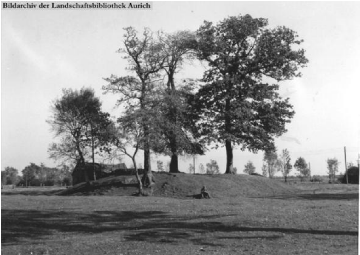
Rest vom Blockhaus
