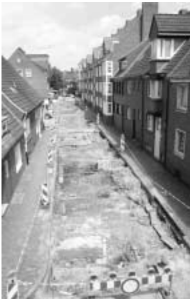
Abb. 17: Emden (24), Blick von der Pelzerstraße in die Emsstraße mit verschiedenen alten Fundamenten (Foto: B. Rasink)
