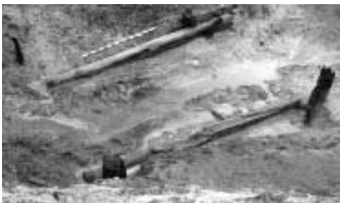
Abb. 21: Detern (26), hölzerne Reste der Brückenkonstruktion im Burggraben (Foto: H. Lange)
