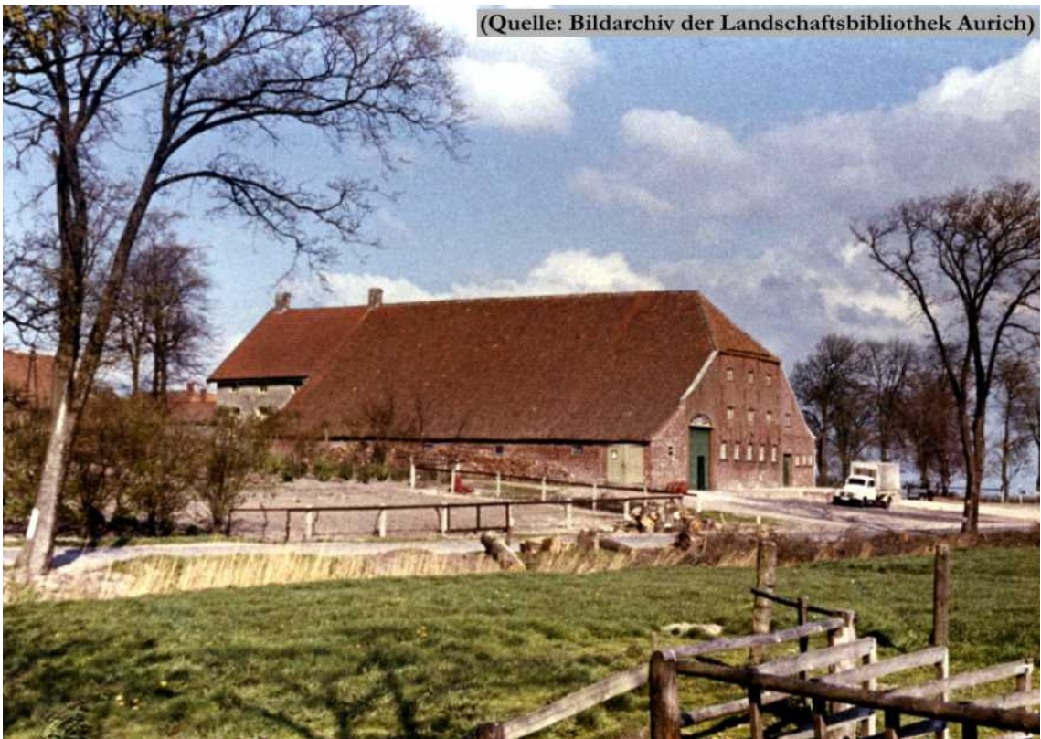
Alte Hofstelle Stromann
