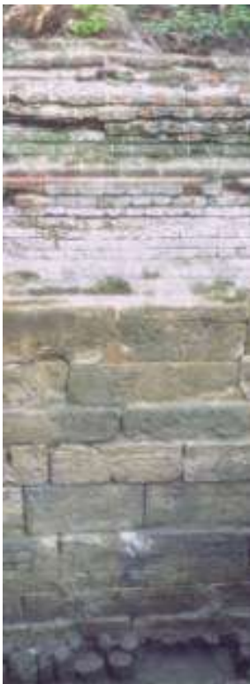
Ausschnitt der Emsmauer während der Ausgrabung. Oben: Backsteinlagen, Mitte: Sandsteinblöcke, Unten: Substruktion aus Holzpflocken.
